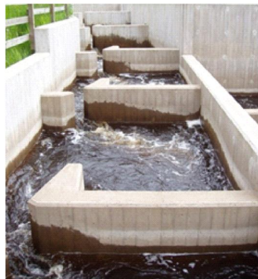
Figur 1. Tekniska lösningar för uppströms fiskpassage. Foton A-D) Olle Calles, E-F) Länsstyrelsen i Västra Götalands Län, Morgan Andersson.
