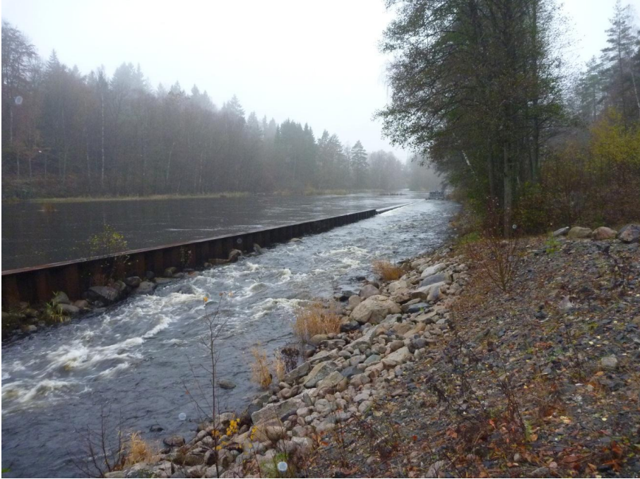
Figur 7. Naturlik ramp (inlöp) vid Hemsjö nedre kraftverk. En stålspons (skiljeväg) separerar huvudfåran från rampen och vid högflöden spiller vatten över skiljeväggen ner i fiskvägen, med start i fiskvägens övre del där väggen är som lägst. Intagsluckorna till rampen skymtar längst bort i bild. Foto: Olle Calles.
