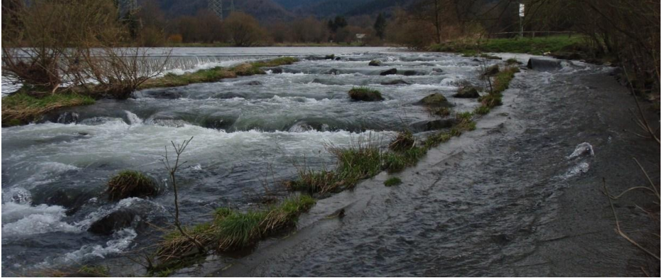
Figur 8. Exempel på en naturlig bassängtrappa vid kraftverket Unkelsmühle, vattendraget Sieg, Tyskland. Till höger i bild syns en ränna anlagd för kanoter. Foto Olle Calles.
