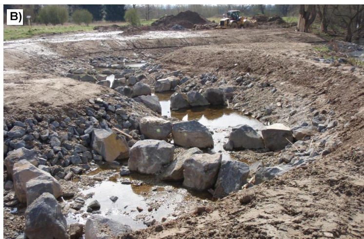
Figur 10. Exempel på naturlika bassängtrappor A) Från vattendraget Roer i Roermond, Nederländerna. B) Bassängkanal under byggnation vid Aggerwehr Troisdorf i Aggars mynning, Tyskland. Foto Olle Calles.
